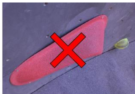
Abbildung 6: Unzulässige Befestigung an einer konkaven Wand
